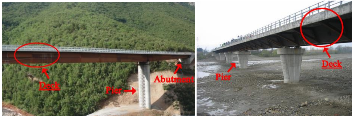
Figure 30. On the left, Viadotto Caballa Nord-Sud, Morano Calabro – Source: [20]. On the right, Ponte sul Torrente Chisone, Macello (TO) – Source: [21]
