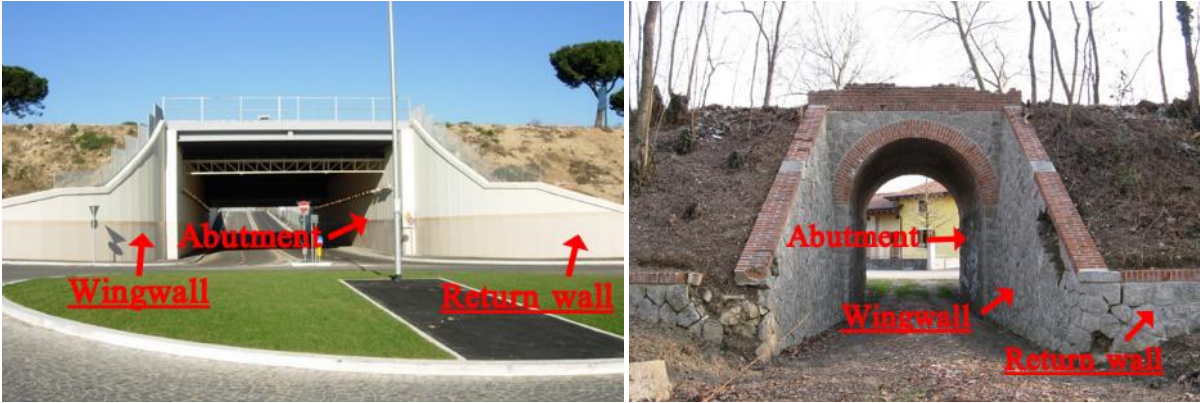
Figure 41. On the left, Sottopasso Manlio Cavalli – Source: [36]. On the right, Sottovia di Loreggia – Source: [14]
